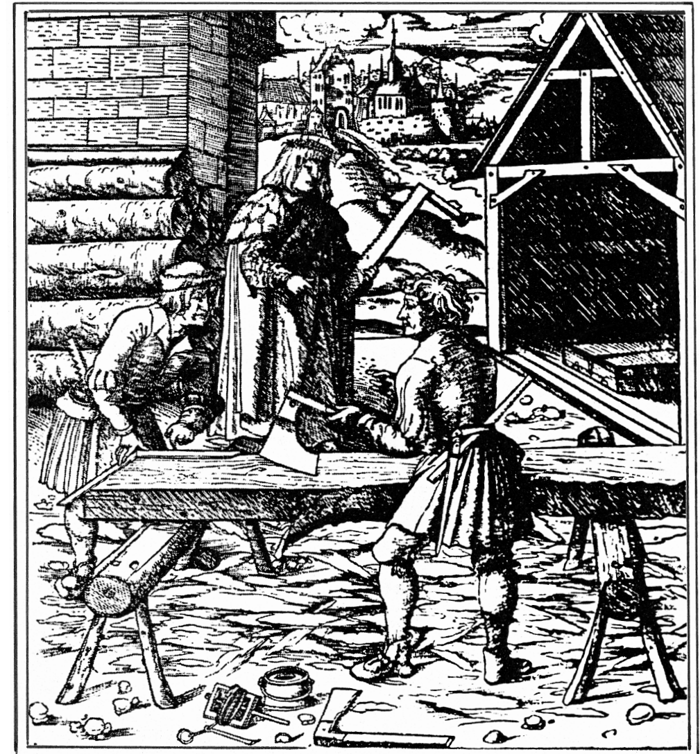
Nous voyons ici l'efficacité du travail d'équarrissage à la grande doloire. La poutre est d'ailleurs soigneusement vérifiée par le contremaître à l'aide d'une l'équerre. Gravure de Hans Leonhard Schöuffelin (Nuremberg, Allemagne, vers 1500)
