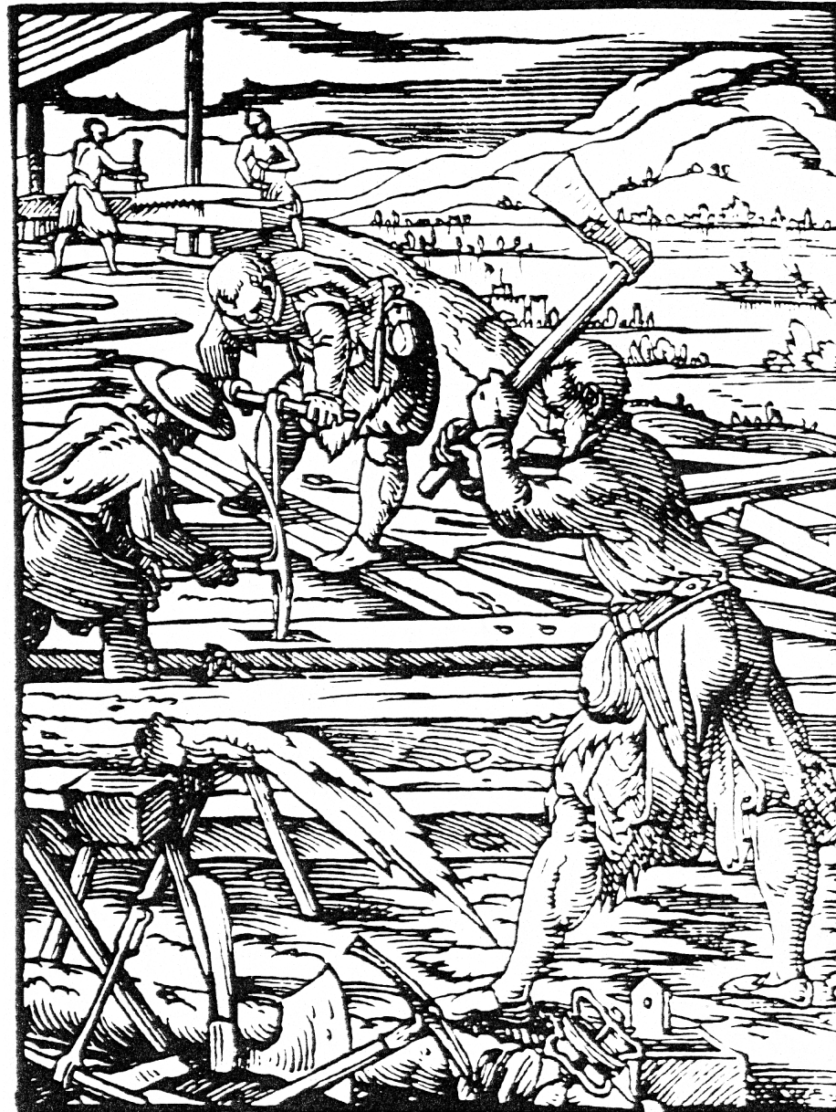
Utilisation d'une cognée pour « équarrir » grossièrement. La doloire au premier plan permettait de « blanchir ». Au second plan, un compagnon creuse une mortaise au piochon. Gravure de Jost Amman (Francfort, Allemagne, 1568)
